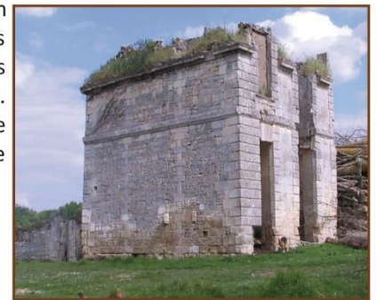
Photo des dépendances. Ce bâtiment d'excellente facture est un témoin de l'architecture du XVII ème siècle. Il est dû à Claude Bonneau Cliché Anthony Bernard 2016.
