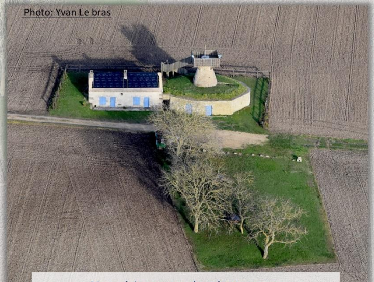
Vue aérienne pendant les travaux,
