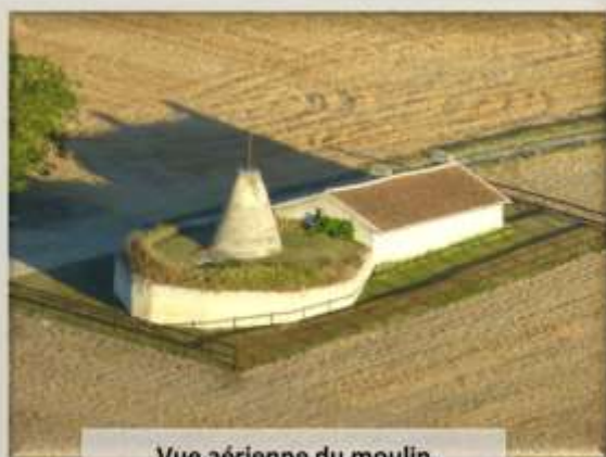
Vue aérienne du moulin
