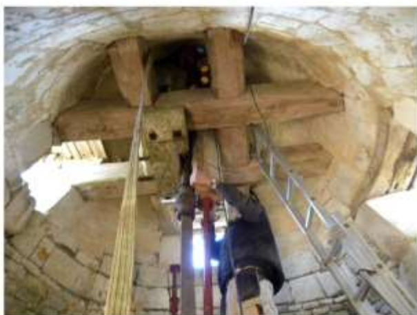
Travaux de mise en œuvre de la plate-forme d'orientation
